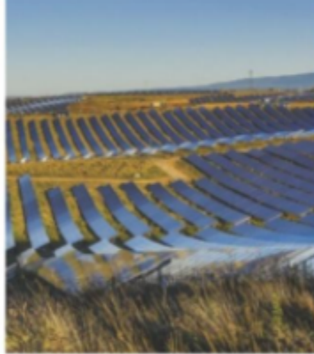
1 Une centrale solaire produit de l'énergie électrique.
